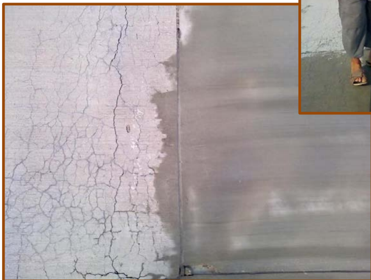
Colmatare fisuri cu silicați solubili
