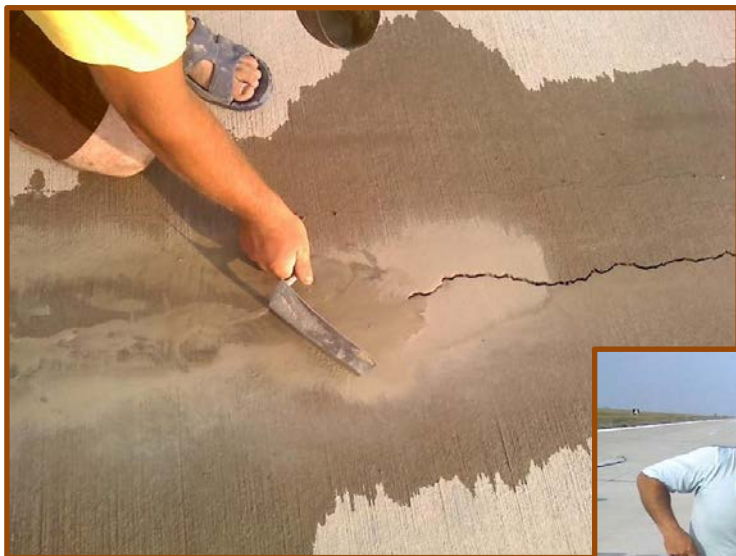
Colmatare fisuri cu silicați solubili
