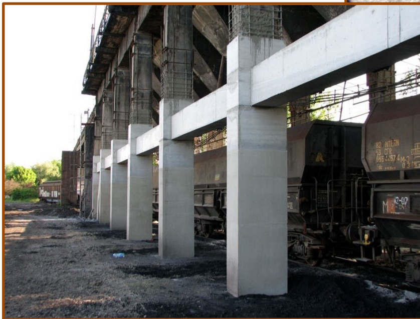
Refacere structurala cu betoane auto-compactante
