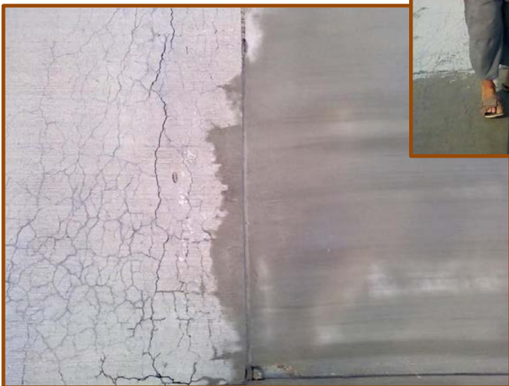
Colmatare fisuri cu silicați solubili
